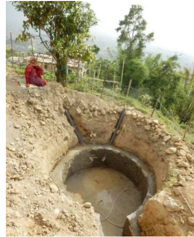
Aufbau einer Biogasanlage | © atmosfair
